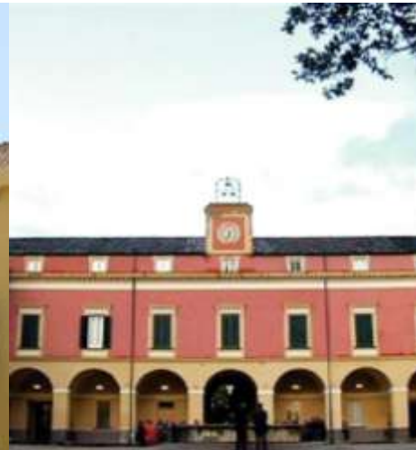
Complesso Real Polverificio Borbonico, Scafati
